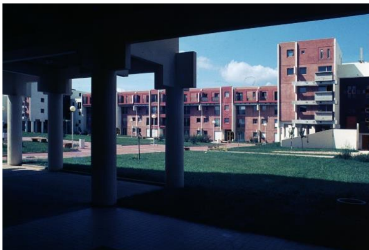
Figure 1 : Vue de la place intérieure de la résidence Grand'Goule à sa livraison en 1980 (archives architecturestudio).
